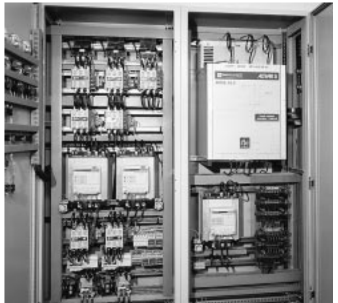
Arrancadores ralentizadores y variador
